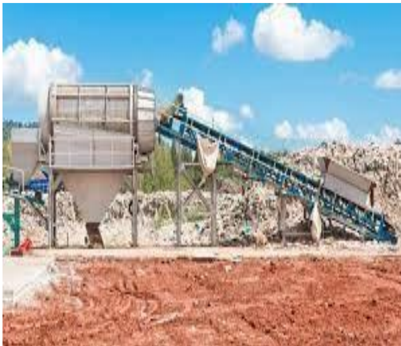
Figura 08- triagem dos resíduos sólidos
