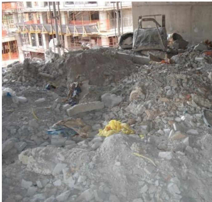
Figura 06- Triagem incorreta de RDC
