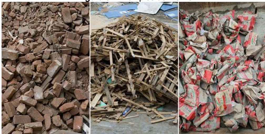
Figura 3 - Exemplos de RCD's.
