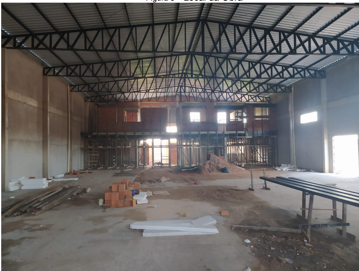
Figura 5 – Local da Obra
