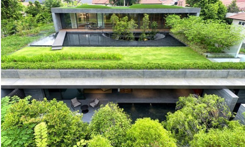
Figura 5- Telhado verde semi-intensivo
