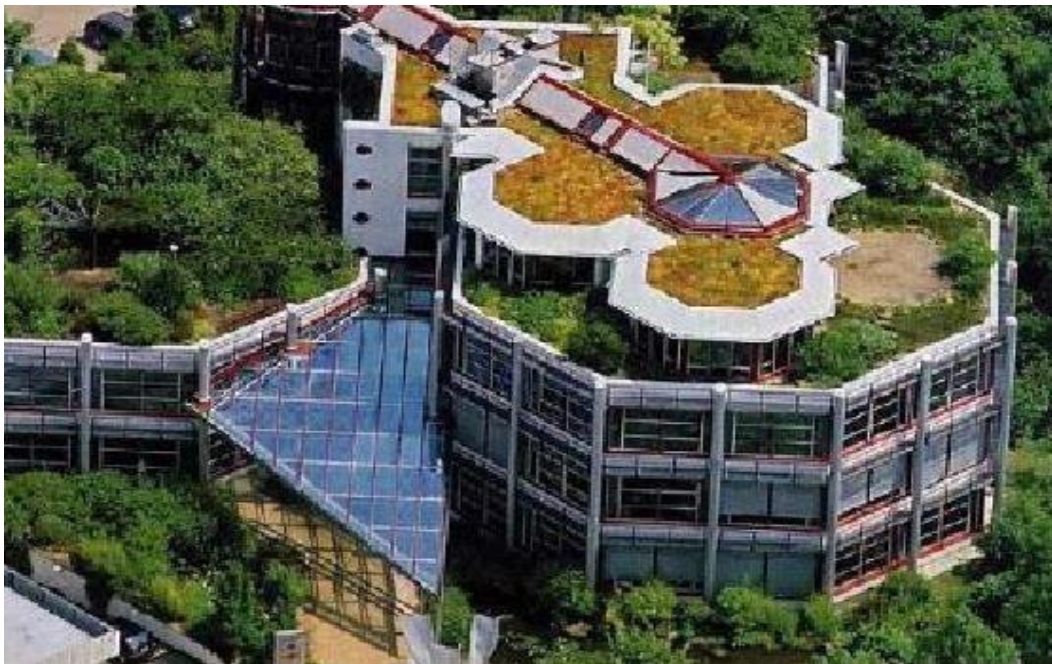
Figura 1 – Conceito de Telhado Verde
