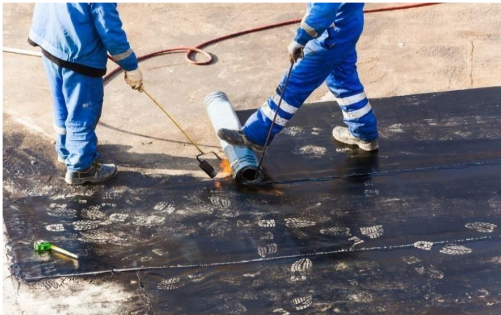
Figura 6- Aplicação da manta asfáltica
