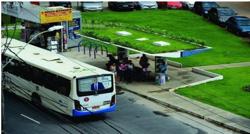
Figura 10-Telhado verde em ponto de ônibus- Salvador
