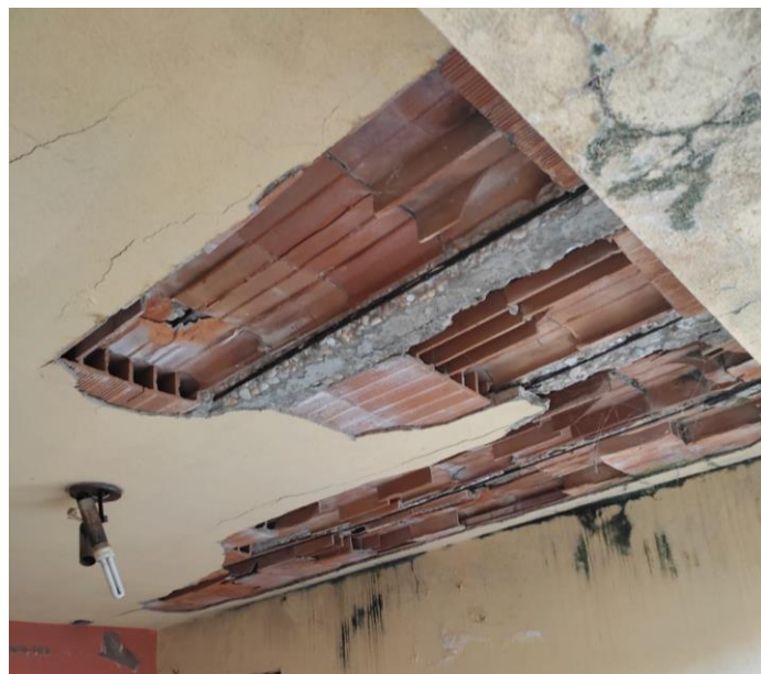
Figura 22 - Teto da laje
