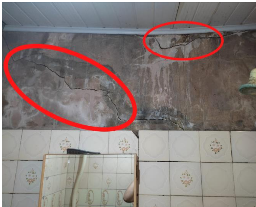
Figura 19 – Aberturas inclinadas no banheiro
