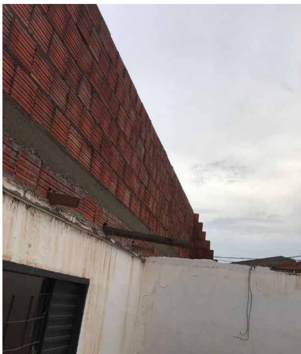
Figura 21 – Construção da platibanda
