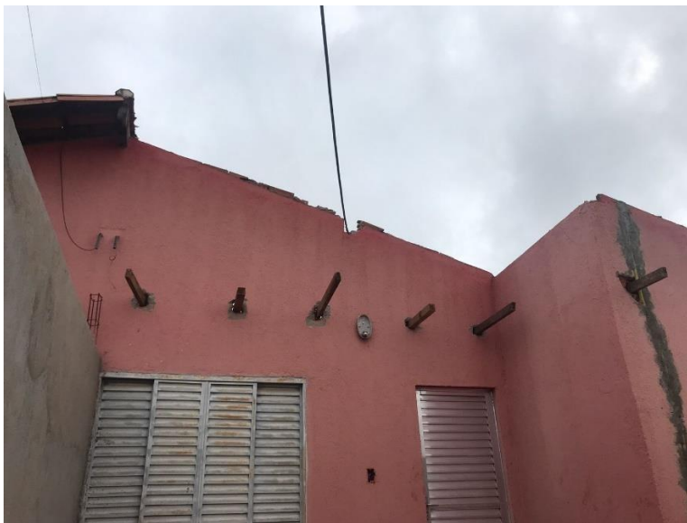
Figura 20 – Remoção do telhado
