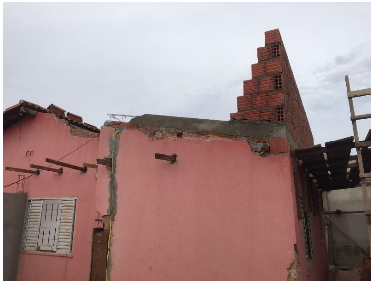
Figura 22 – Vigas para amarração da casa
