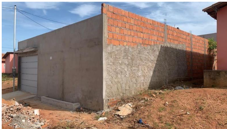
Figura 19 – Construção muro finalizado
