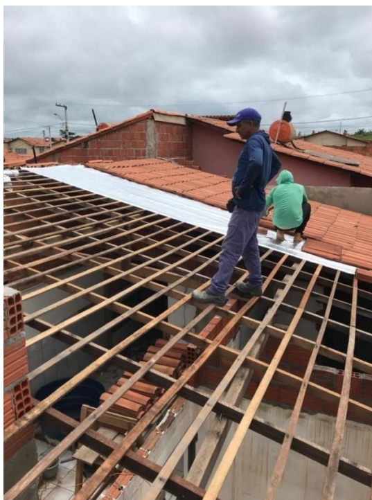
Figura 25 – Instalação do telhado com manta térmica
