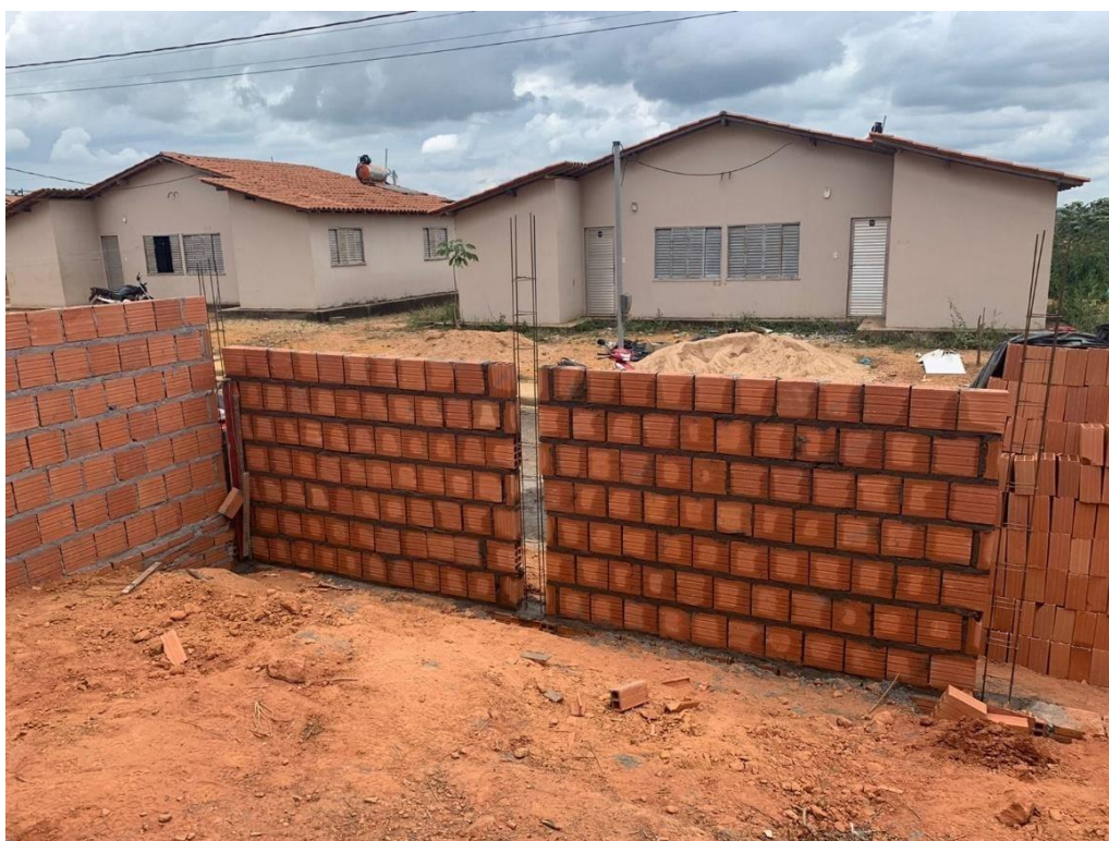
Figura 17 – Levante Muro
