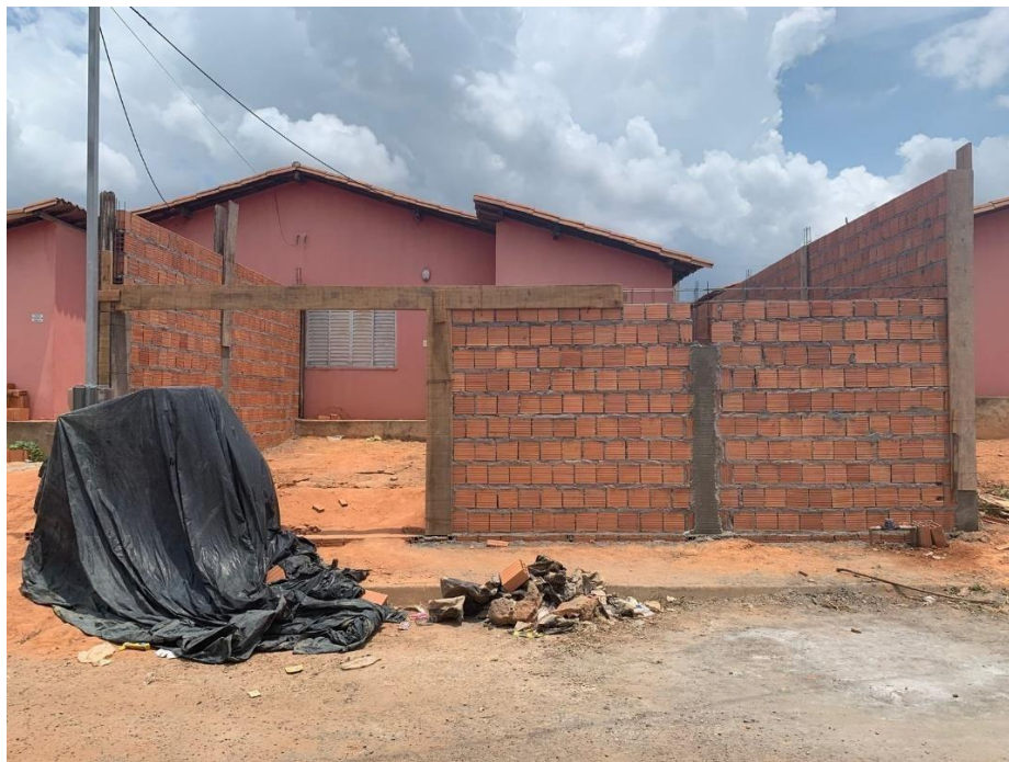
Figura 18 – Construção do Muro frontal
