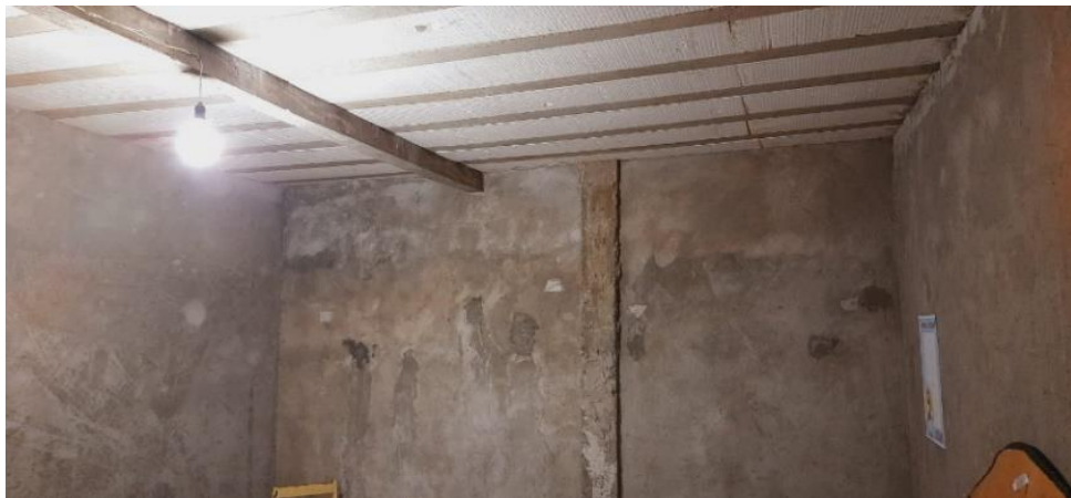
Figura 5 – Viga construída fora do pilar
