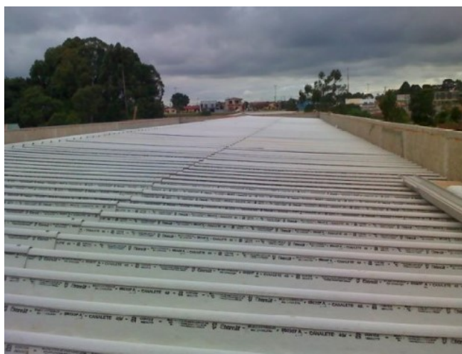
Figura 4 - Cobertura em fibrocimento
