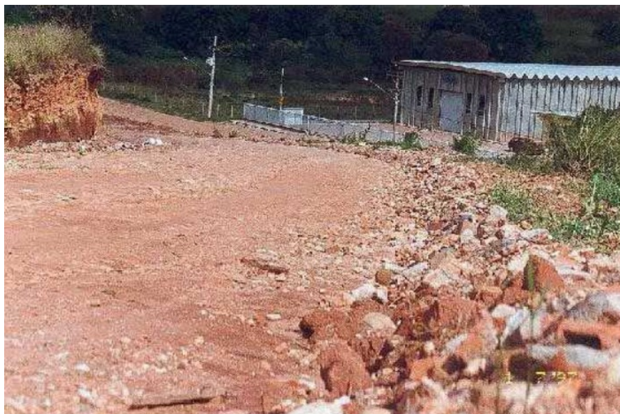
Figura 3 - Recuperação de via em Jandiaí/SP com uso de RCD in natura
