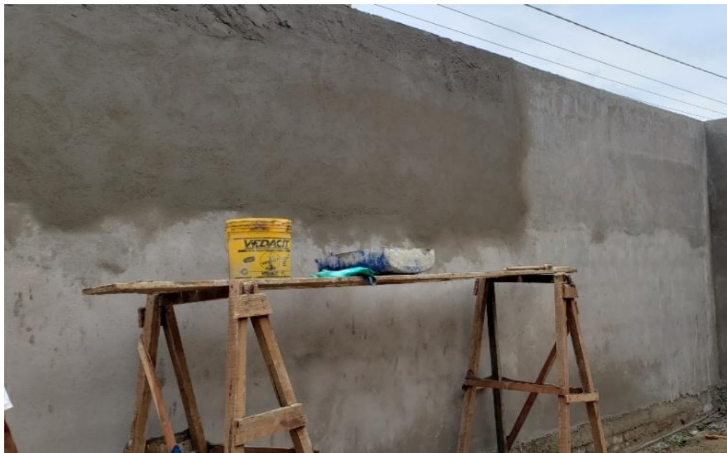
Figura 8: Trabalho em altura
