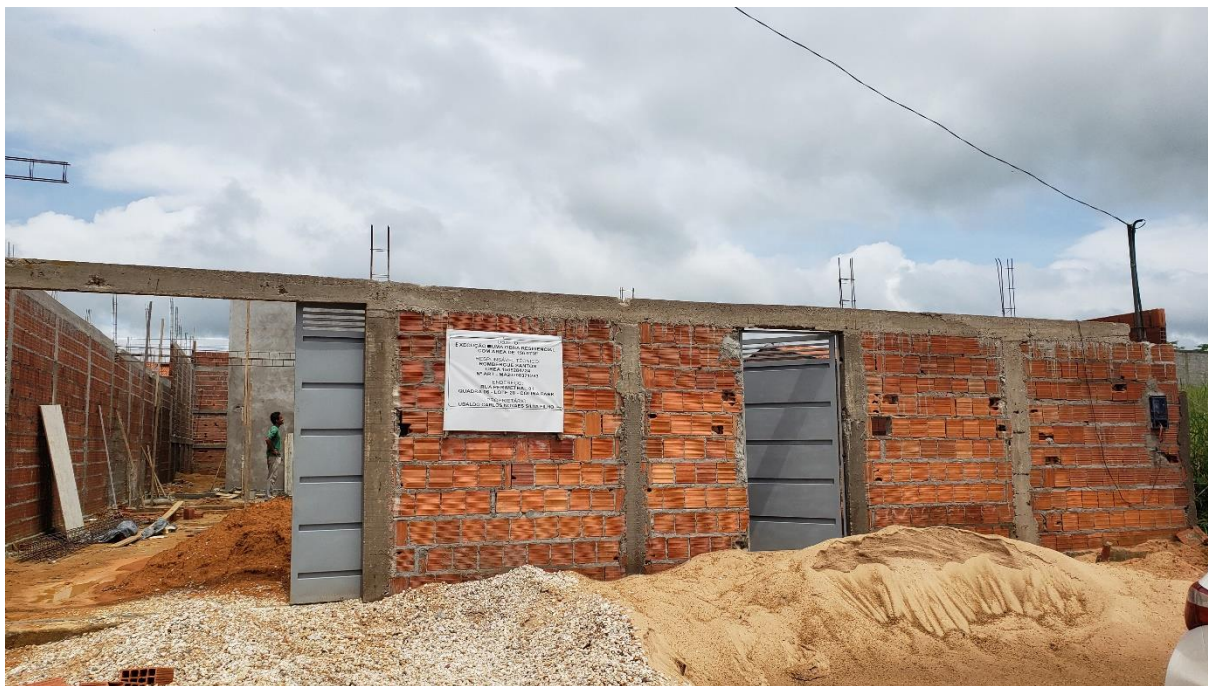
Figura 11: Acesso a obra
