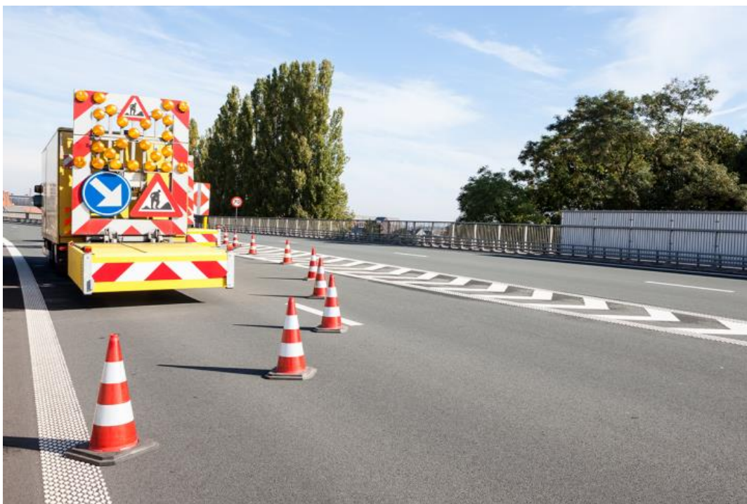
Figura 1: Sinalização de segurança
