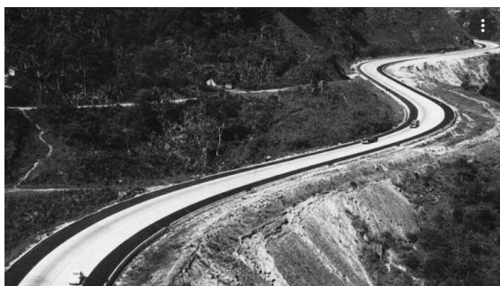
Figura 2 - Primeira estrada pavimentada, com revestimento asfáltico
