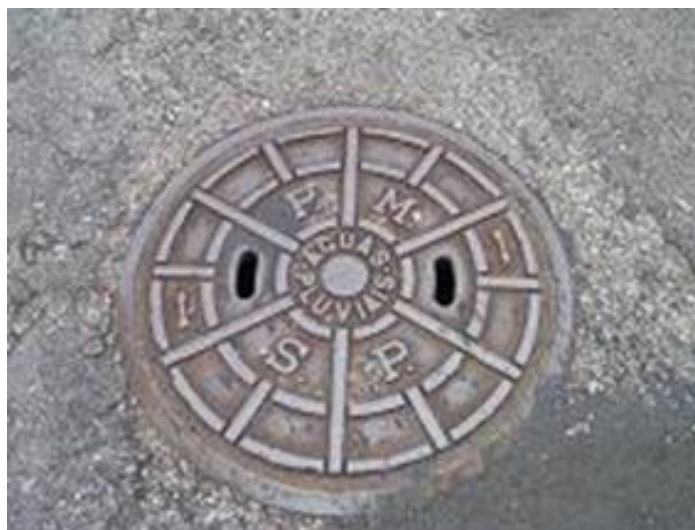
Figura 4 - Poço de visita
