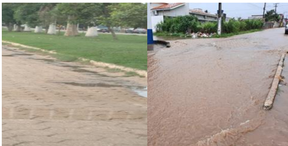
Figura 12 - Av. Presidente Médici e Rua das Mangueiras respectivamente
