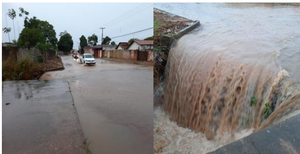
Figura 14 - Bueiro na Rua José dos Reis Feitosa
