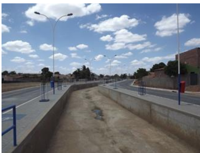
Figura 6 - Macrodrenagem Urbana do Canal do Frango - Patos (PB)
