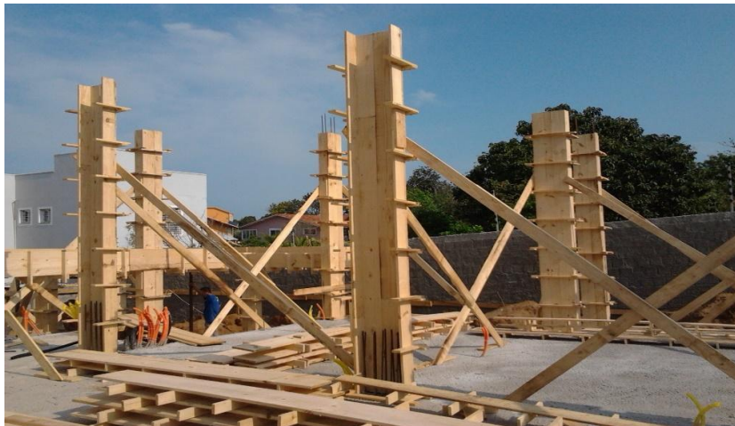
Figura 1 – Utilização de tabuas para forma de pilar.
