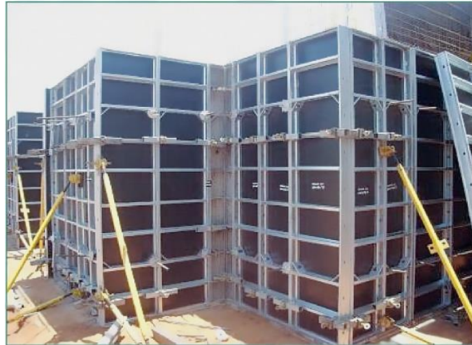
Figura 4 – Forma de alumínio.
