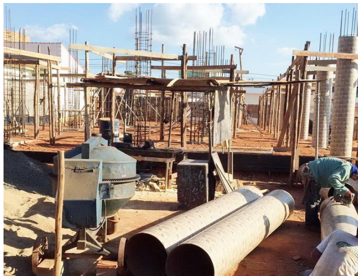
Figura 5 – forma de papelão para pilar.
