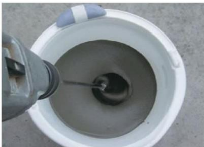
Figura 19 - Mistura realizada com agitador mecânico
