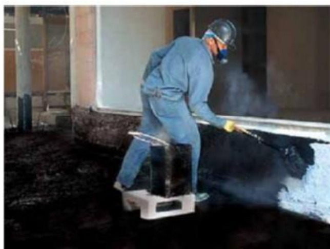
Figura 23- Aplicação a quente de asfalto modificado
