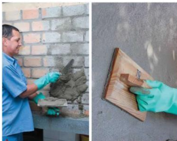
Figura 17. Aplicação da argamassa com desempenadeira de plástico ou madeira
