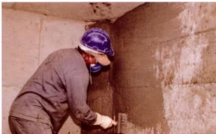
Figura 20 - Aplicação de argamassa polimérica
