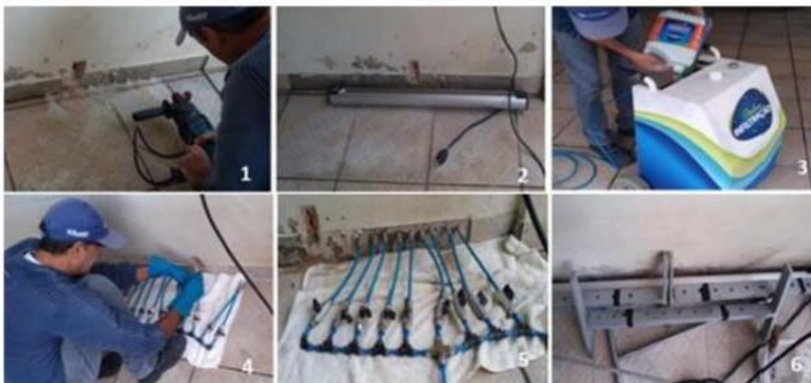
Figura 21 - Processo de injeção Cristalizante passo a passo.
