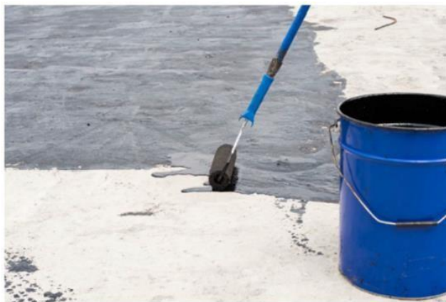
Figura 25 - Imprimação do substrato
