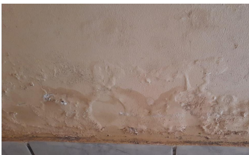
Figura 32. Fase formação de bolhas
