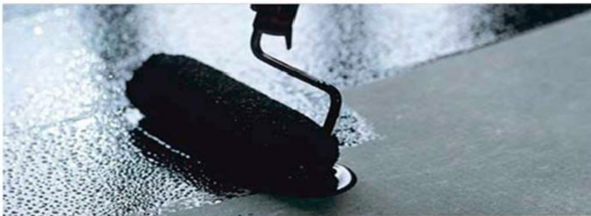
Figura 22. Aplicação a frio de emulsão asfáltica
