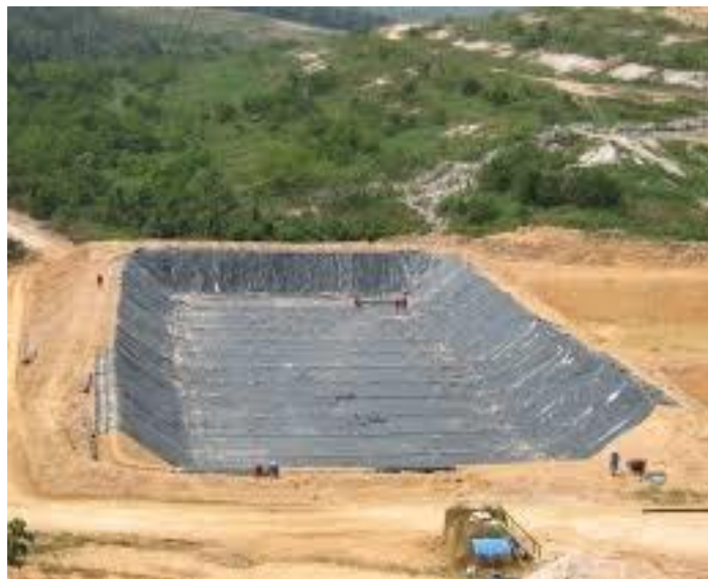
Figura 33 – Área de aterro sanitário
