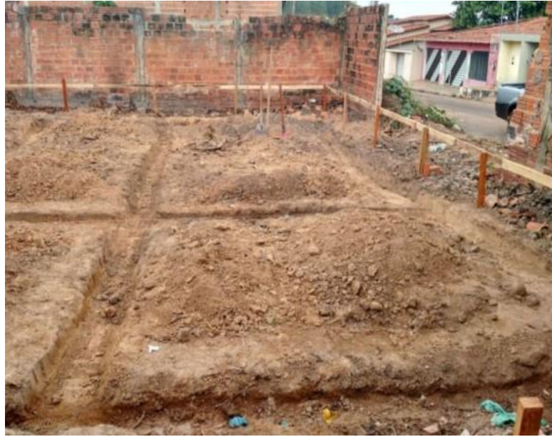
Figura 07 – Canteiro da obra 2.
