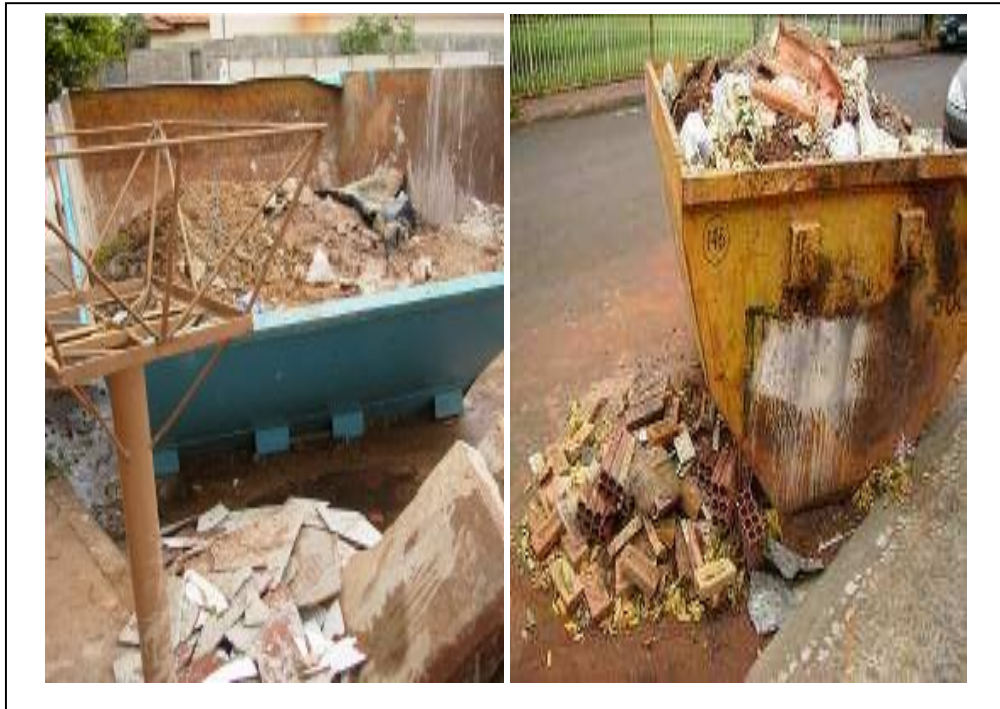
Figura 26: Resíduos da obra depositados fora da caçamba
