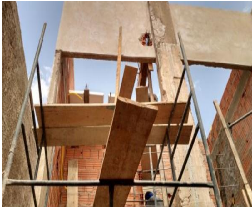
Figura 06 – Canteiro da obra 1
