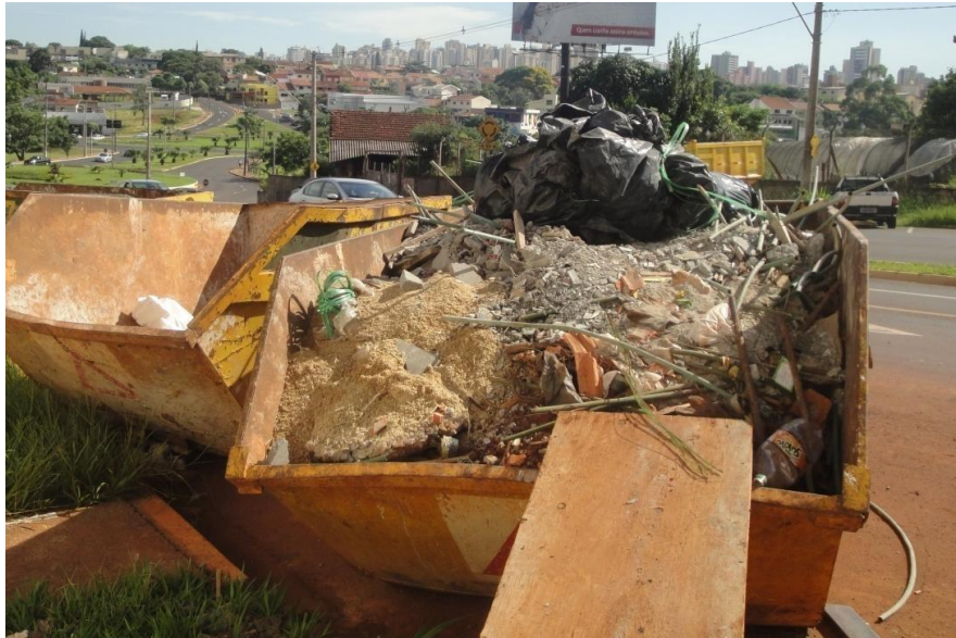
Figura 15: Caçamba estacionada disposta na rua.
