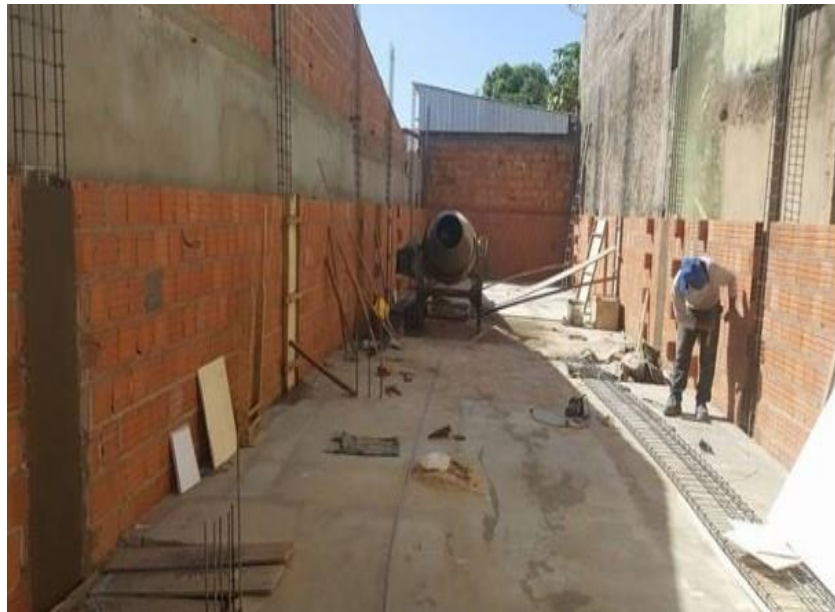
Figura 08 – Canteiro da obra 3.
