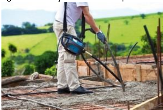
Figura 7- Vibração do concreto por imersão
