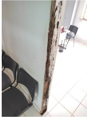
Figura 13 - Portal deteriorado.
