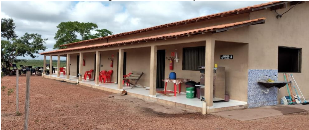
Figura 1 – Casa de Apoio
